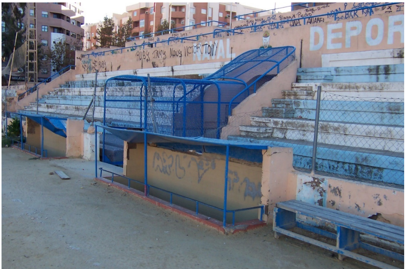
Los Juncos, meses antes de su demolición
