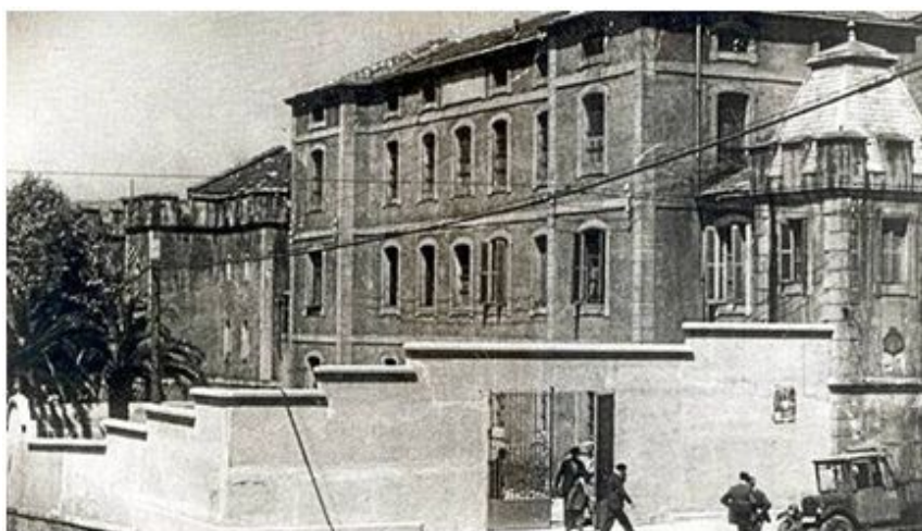
Fachada de la cárcel de Larrinaga. Fuente: Fundación Sabino Arana-Archivo del Nacionalismo Vasco.
